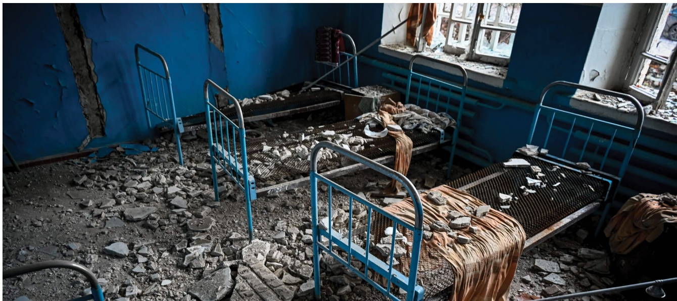
Палата у пошкодженій будівлі лікарні поблизу міста Куп'янськ, Харківська область. Фото: Sergey Bobok/AFP/Getty Images, зроблено 15 грудня 2022 року.
